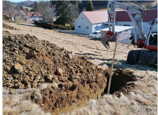
*Bild 7:* Durchführung Schurf S2
