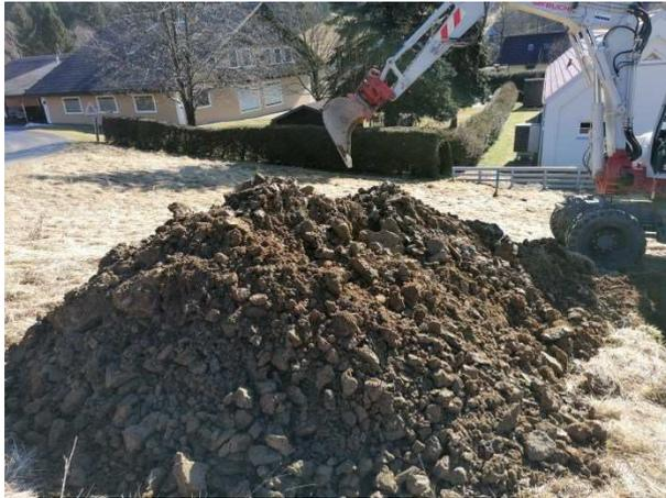
*Bild 6:* Durchführung Schurf S1
