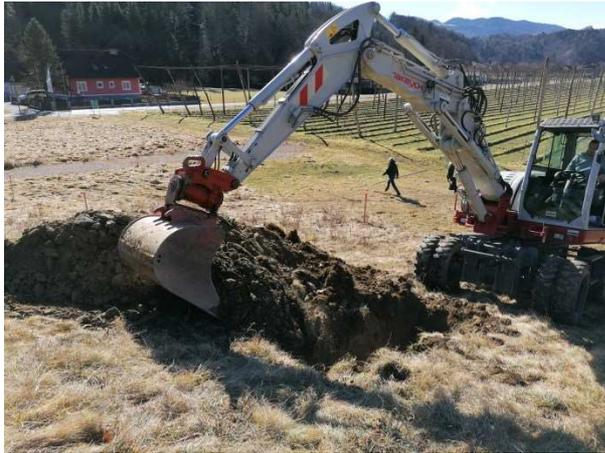
*Bild 10:* Durchführung Schurf S3
